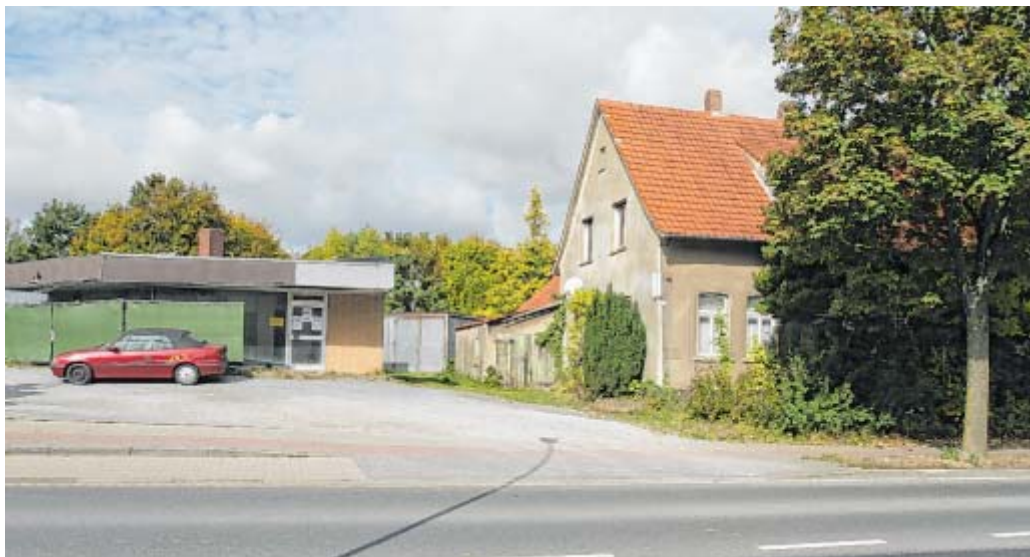
Haus und Laden sollen weichen: Seit 2014 hat die ehemalige Gärtnerei geschlossen. Nun soll sie abgerissen werden. FOTO: N. SIELERMANN
