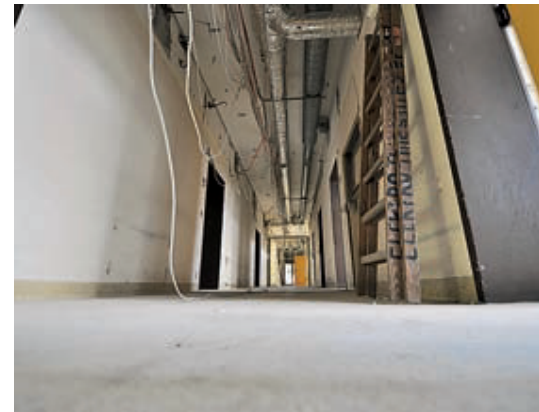
Eine von vielen Baustellen der Mühlenkreiskliniken in den letzten Jahren: Im Krankenhaus Bad Oeynhausen wurde eine ehemalige Intensivstation zu einem komplett neuen Ambulanzbereich umgestaltet.
