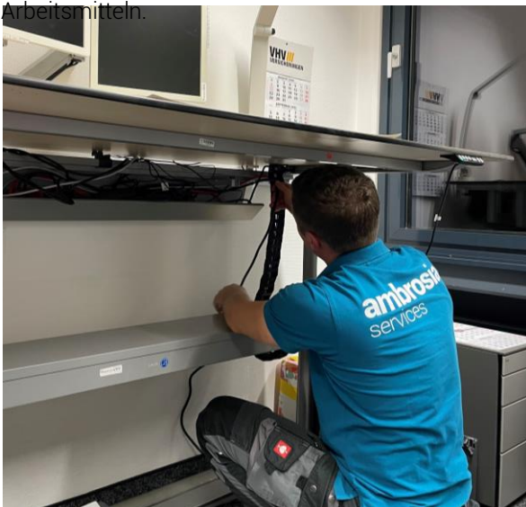
Abb.: Sachgemäße Leitungsverlegung © copyright ambrosia
